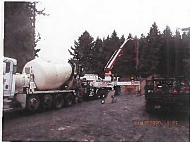
Concrete pour for ringwall footing
