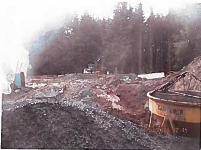
Concrete pour for ringwall for CW1
